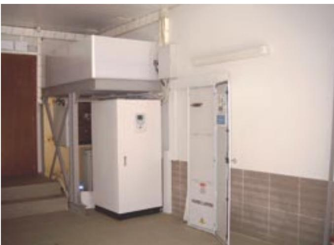
Рис.4 Блок бесперебойного питания с увеличением мощности
