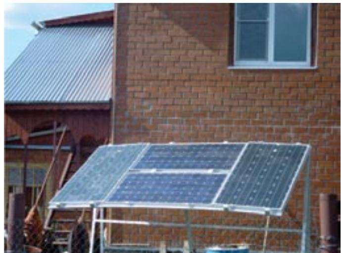
Рис.2 Солнечная электростанция 0,5 кВт
